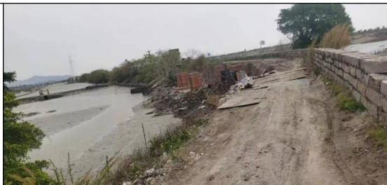
线路通道（养殖场机耕路）现状图3
