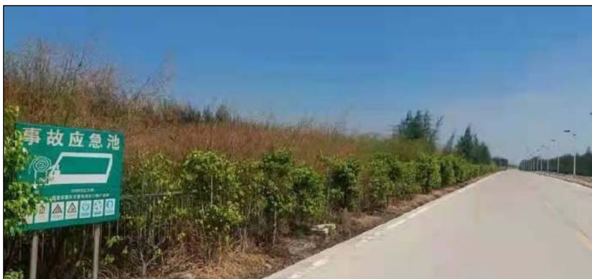
图 3.3-3 园区事故应急池
