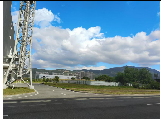
厂区西北侧福英泰
