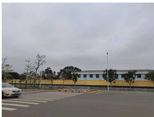
厂区南侧道路及部队用地
