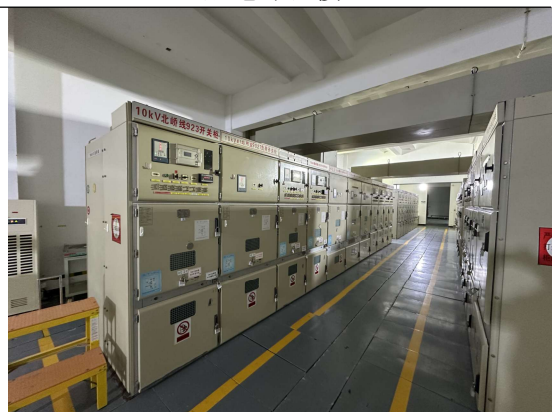
10kV 配电装置室
