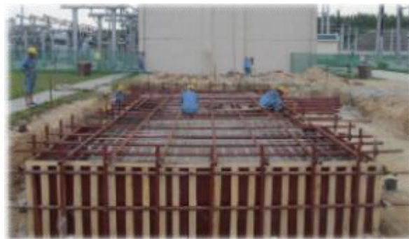
基础模板安装加固外露基础清水砼效果
