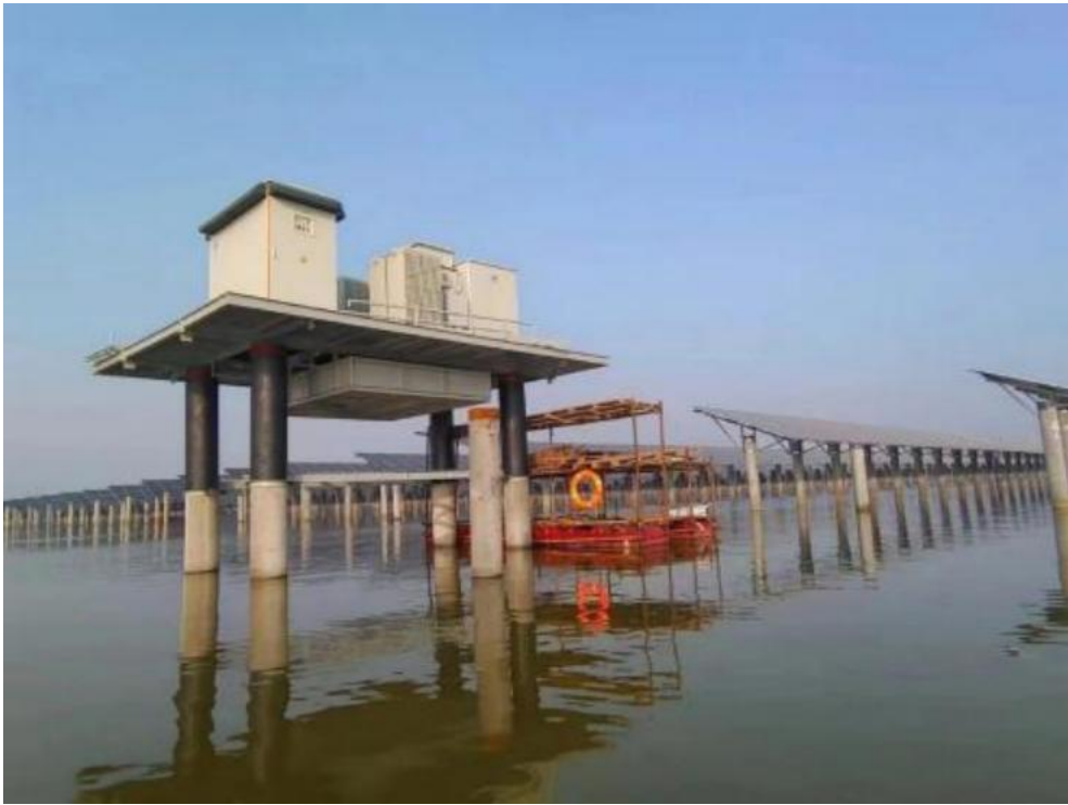
图 2.5-13 逆变器安装施工图
