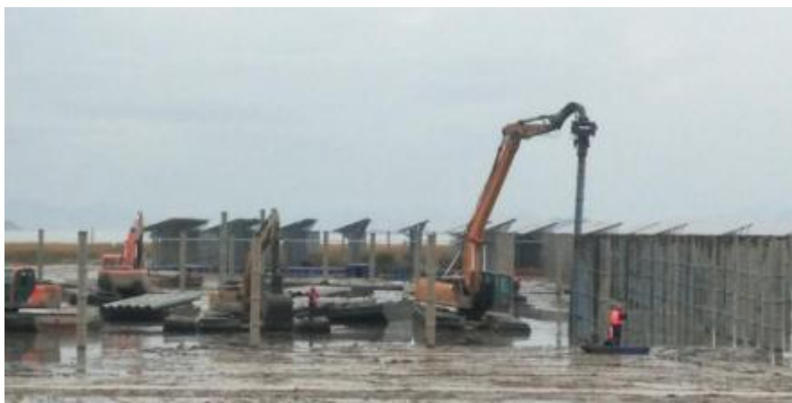
图 2.5-8 沉桩施工作业图
