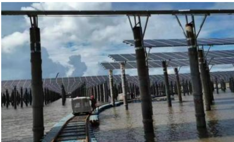
图 2.5-10 浮台轨道施工图
