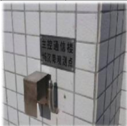
沉降观测基准点建筑沉降观测点
