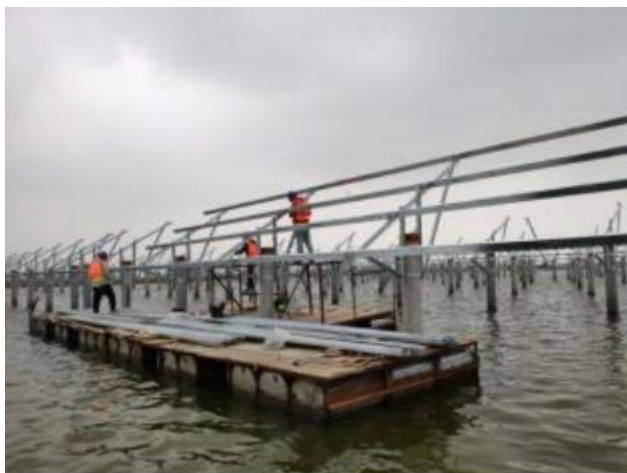
图 2.5-11 组件支架安装施工图
