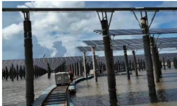
图 2.5-3 组件运输施工图
