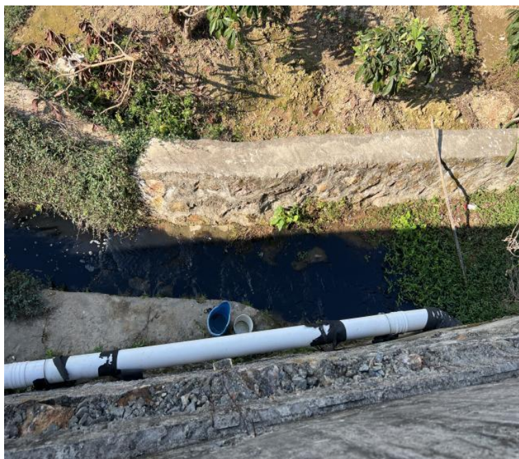
图 5.3-99 一二级保护区管网破损情况
